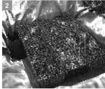
Étape 2 – Installez la voûte Snorkel MC , le module Centipede MC et les matrices d'eau AquaBlox MC
